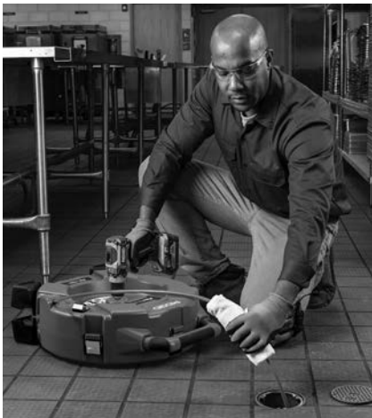
Abbildung 13 – Auftragen von Schmiermittel auf die Spiraleummantelung
