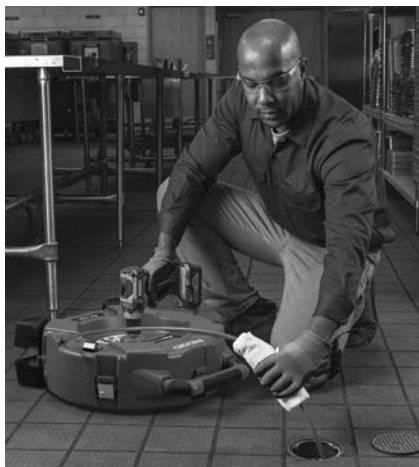
Figura 13 – Aplicar lubrificante ao revestimento do cabo
