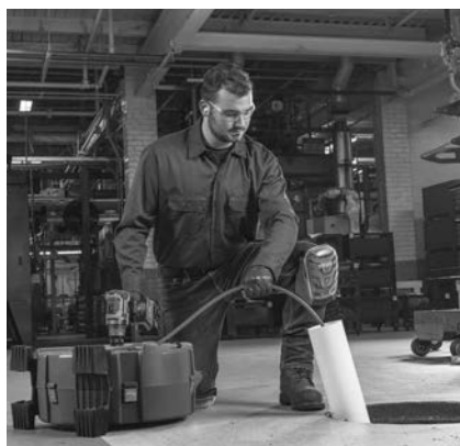
5-сурет – Ағын құбырына кіру орнын құрылғының кабель шығысының 3 фут шегінде созу үлгісі
