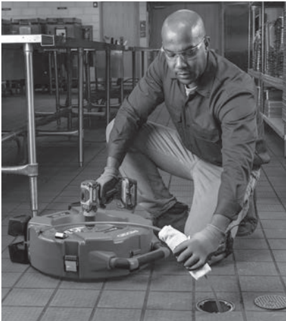
Figura 13 – Aplicación de lubricante sobre la vaina del cable
