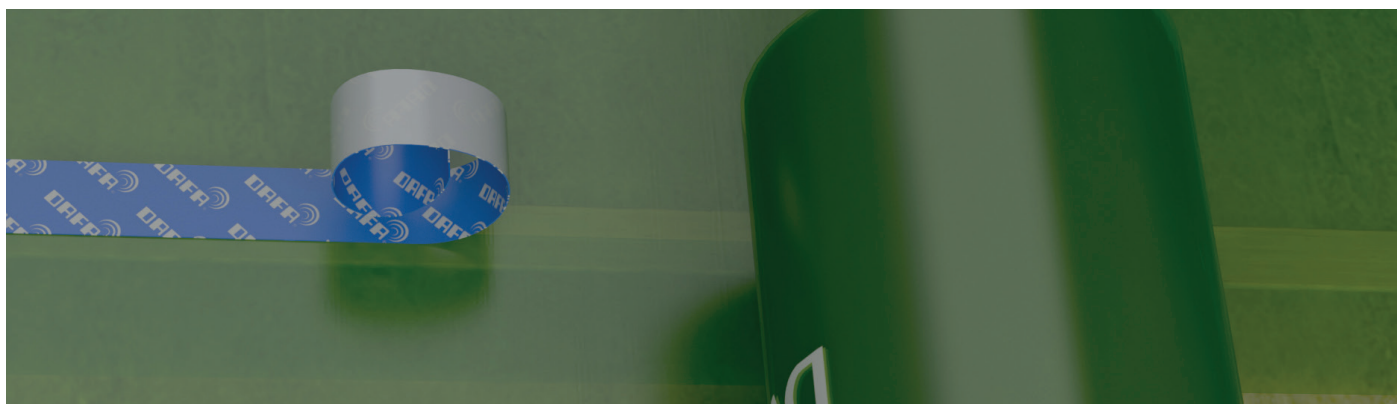
Dampsperrfolien monteres med overlegg og tapes med DAFA dampsperrtape.
